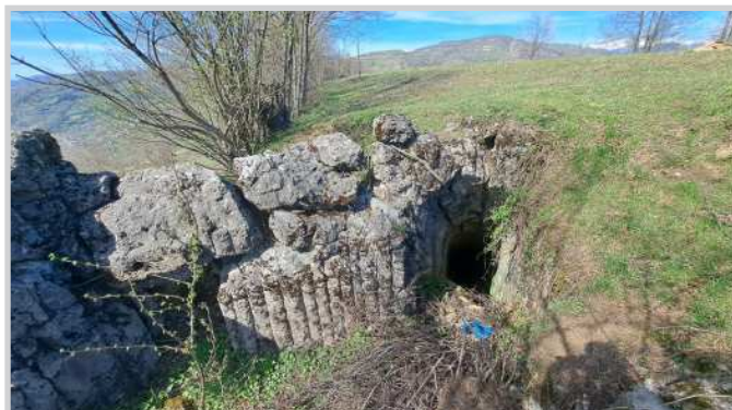
Fig. 9. Cazemată din beton și tunelul de ieșire spre ea din subteran
