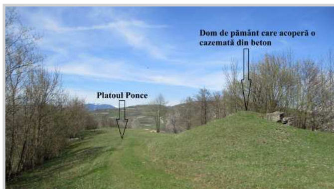
Fig. 10. Suprafața culmii Ponce și o cazemată (C7) acoperită de pământ
