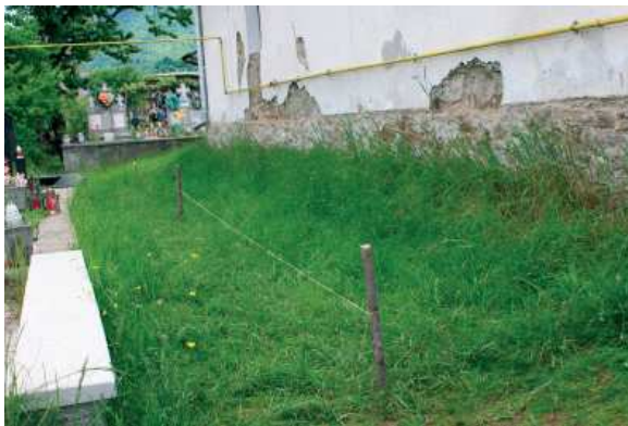
Fig. 2. Detaliu spațiu biserică = cimitir actual latura sudică.
