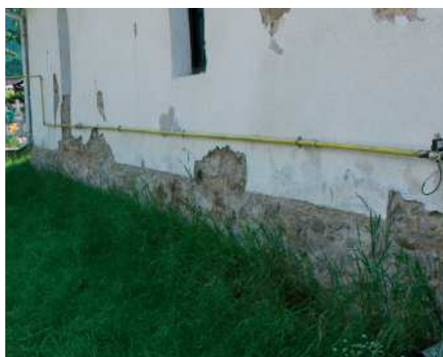
Fig. 3. Detaliu demantelare zid efectuată anterior cercetării.
