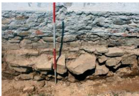
Fig. 3. Secțiunea S1, intervenție în zona fundației cu lespezi de piatră.
