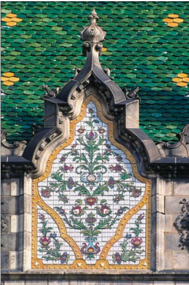
Figura 3. Detaliu de fațadă². Palatul Poștei. Budapesta. Arhitect Odön Lechner.
